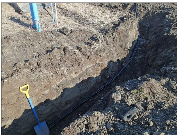
Havainto A:n, N 6746703 E 371457, tumma maakerros näkyy kuvassa lapion oikealla puolella, hieman sen puolivälin yläpuolella. Kaivannon reunan päällä näkyy vesijohtojen venttiileitä. Pohjoiseen.
